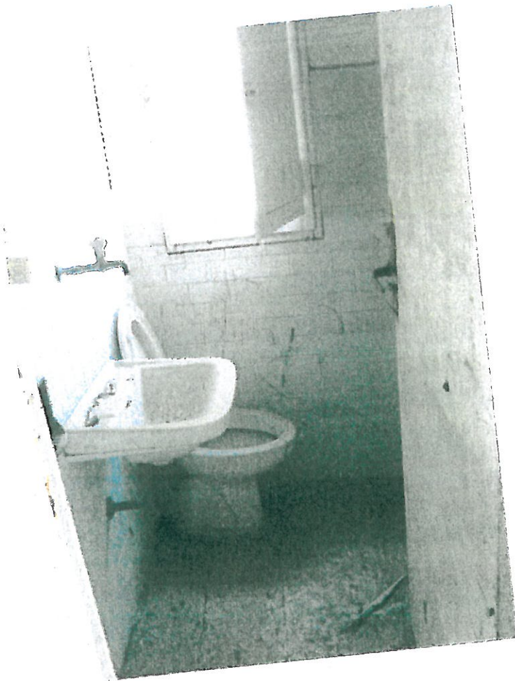
4 – Vista del bagno destro
