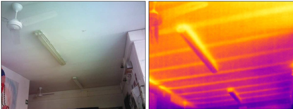
Foto n°1-2 - Individuazione della tramatura caratteristica dell'intradosso del solaio dell'Ingresso al piano terra.
