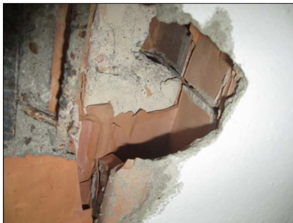
Foto n°9 - Particolare della geometria interna della pignatta che realizza il sistema di alleggerimento del solaio.
