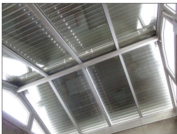
Foto n°7 – Vetrata che sormonta lo spazio centrale dell'edificio.
