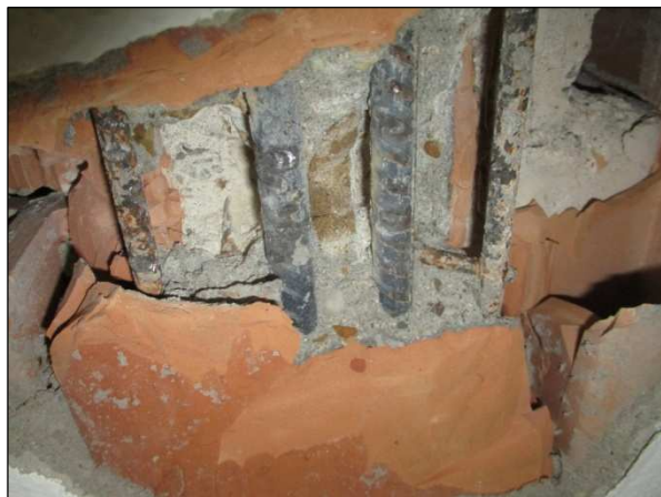
Foto n°10 - Dettaglio del travetto semiprefabbricato in cui osservabili le barre di armatura.
