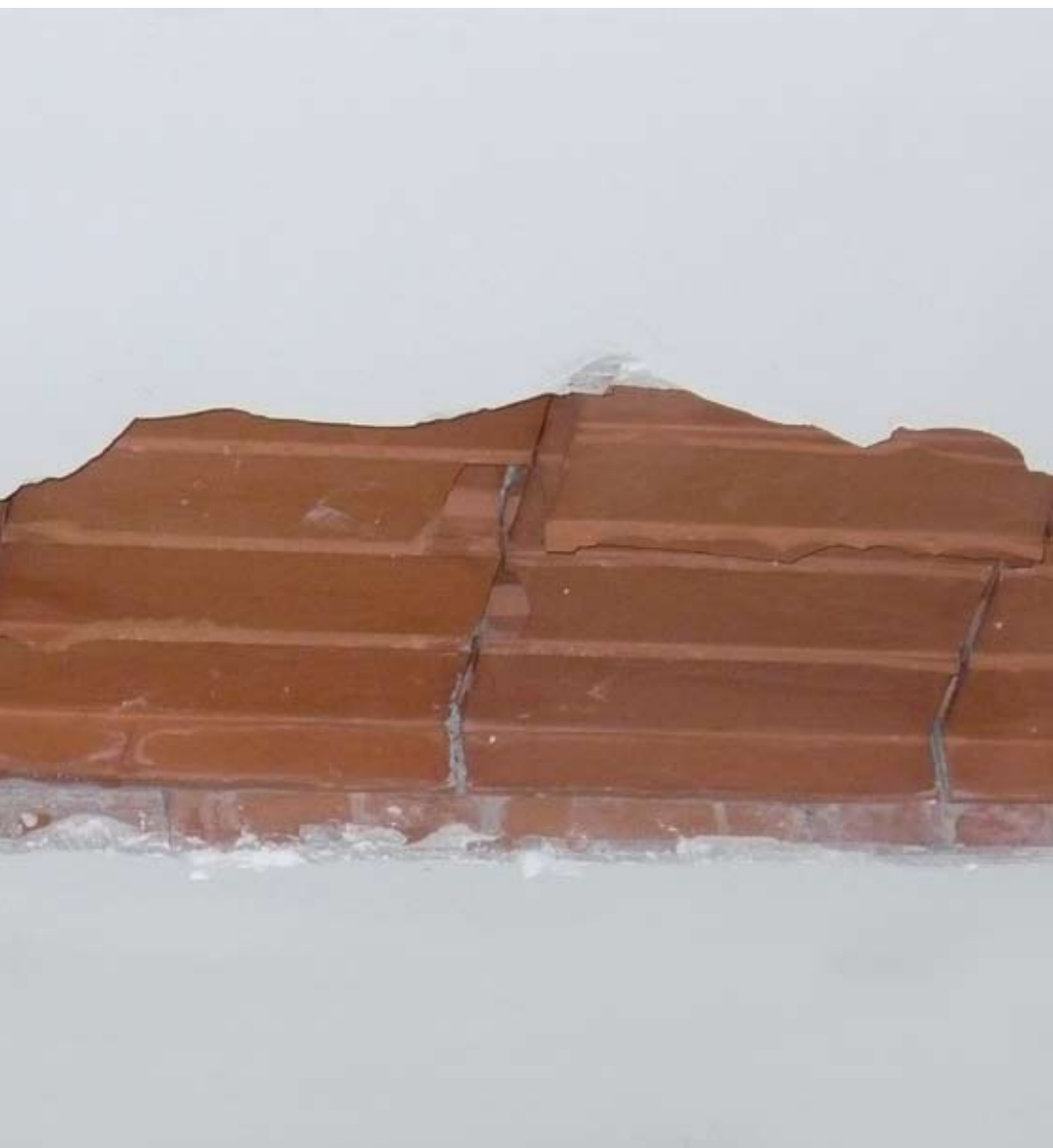
■ Esempi di solai danneggiati dal fenomeno dello sfondellamento.
