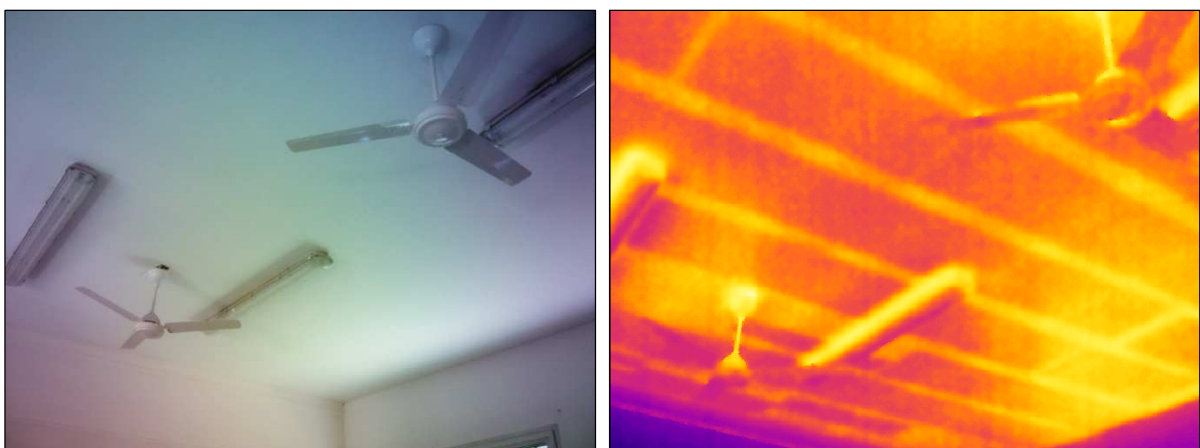
Foto n°3-4 - Scansione del plafone dell'Aula 2 al piano terra osservata durante l'analisi termografica; è possibile constatare la presenza di un'orditura portante che ammette passo costante ed omogeneo.
