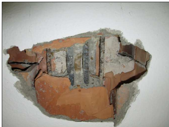
Foto n°8 - Individuazione della Tipologia Solaio 1; demolizione eseguita nel Bagno 3 al piano terra.
